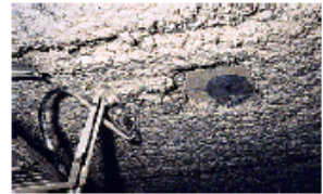
Flocage de plafond
