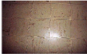
Dalles de sol
